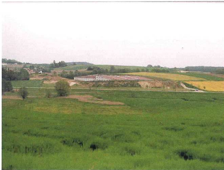
Gewerbegebiet Tödtenried - tiefe Einschnitten in Hang
